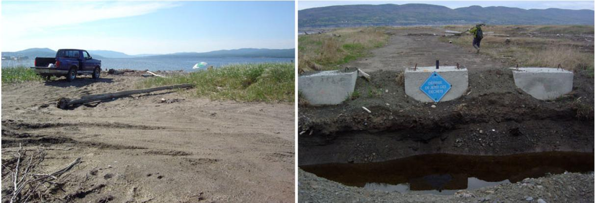
À gauche, érosion du cordon littoral. À droite, tranchée creusée en 2006 afin d'empêcher le passage de véhicules moteur. L'expérience s'est soldée par la création de deux voies de contournement.
